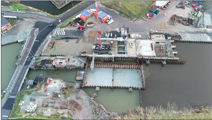
Afbeeldingen: bouwkuip van de nieuwe sluis
